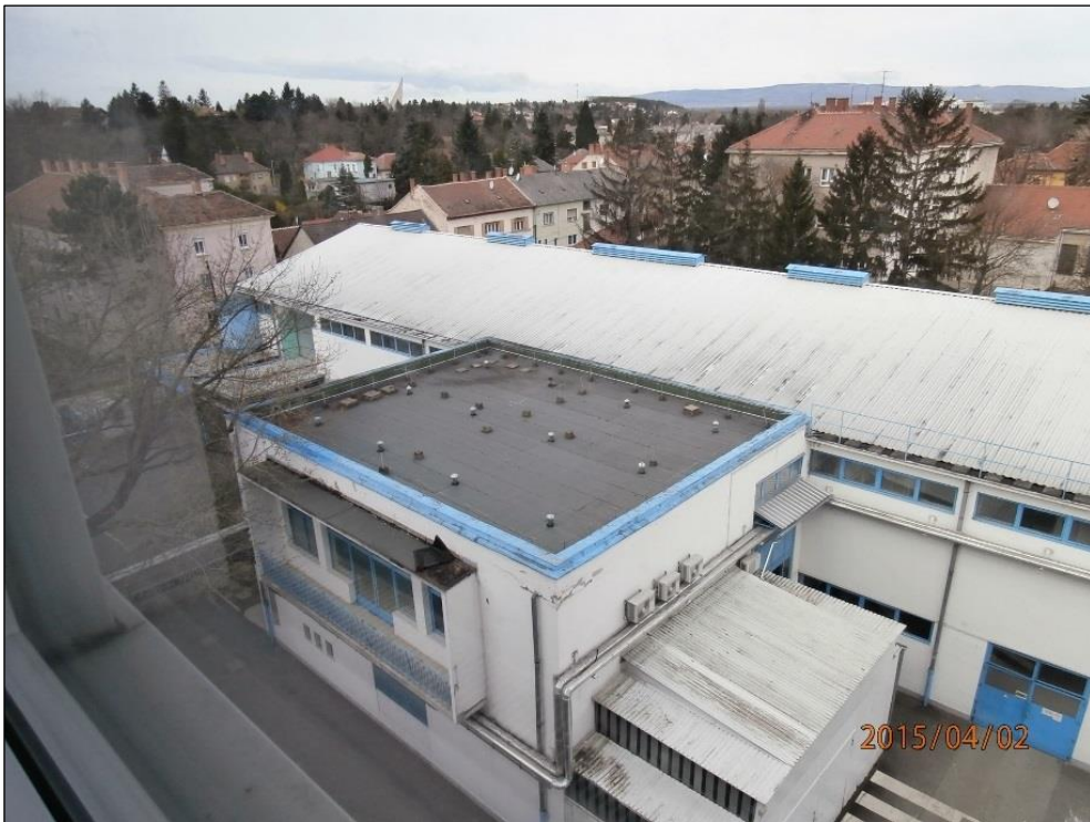
13. ábra - 18. számú épület lépcsőház és szociális blokk 2015.
