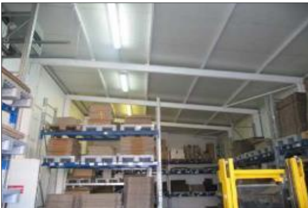
16. ábra - 20. számú épület raktárrész 2014.
