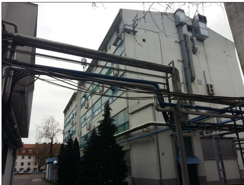
34. ábra - a jelenlegi közműgerincvezeték kialakításának módja
