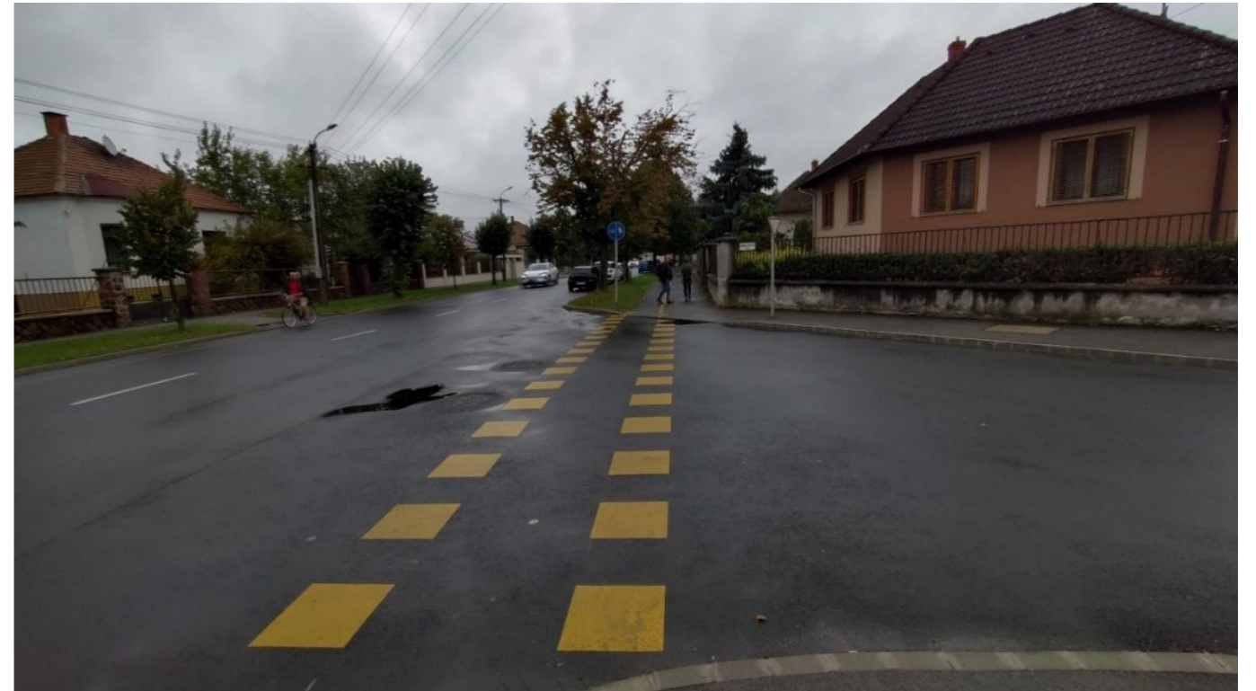
73. ábra: Taktilis burkolati jelekkel és süllyesztett szegéllyel ellátott kerékpáros átvétel (fotó: Együd Marcell)
