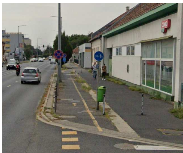
103. ábra: Zanati úti irányhelyes létesítmények hibái: karbantartás hiánya, buszöbölbe vezetett kerékpárút, szembekerékpározás
