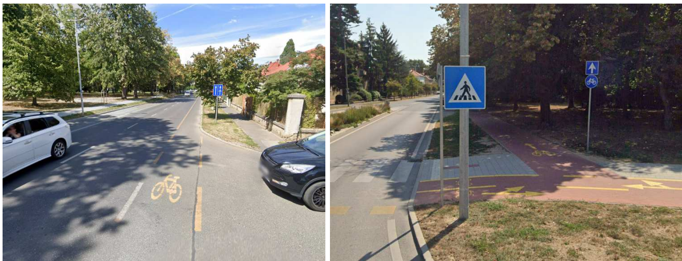
96. ábra: Jókai Mór utcai kerékpáros létesítmények 1.: egyoldali kerékpársáv (NY-i oldal), egyirányú kerékpárút szakasz (K-i oldal)
