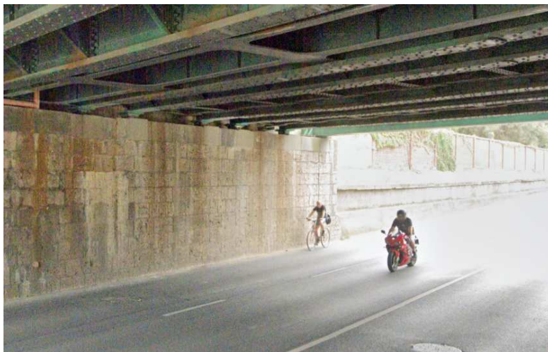
217. ábra: Kerékpározás a Zanati úti aluljáróban
