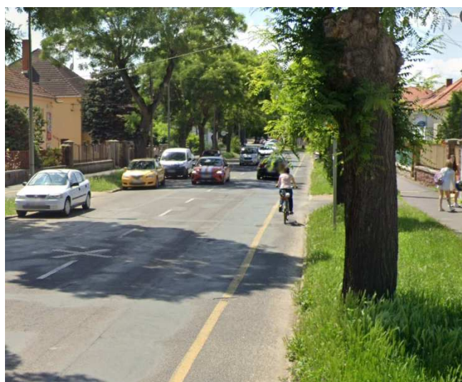
99. ábra: Északi körútrész kerékpáros létesítményei: egyirányú gyalog- és kerékpárút (É-i oldal), egyoldali kerékpársáv (D-i oldal)
