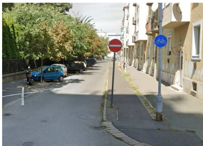
151. ábra: Liszt F. utca, egyirányú aszfalt kerékpárút szakasz
