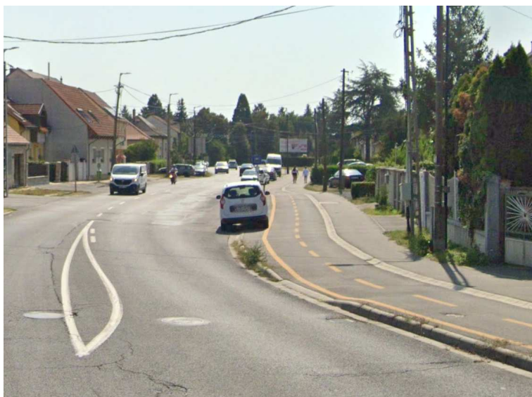
83. ábra: Elválasztott aszfalt gyalog- és kerékpárút szakasz, „K” szegéllyel
