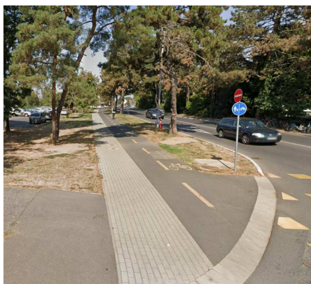
84. ábra: Elválasztott gyalog- és kp.út, térkő járdarésszel
