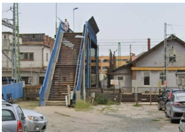
213. ábra: Vasút u. 20. melletti meglévő gyalogos felüljáró
