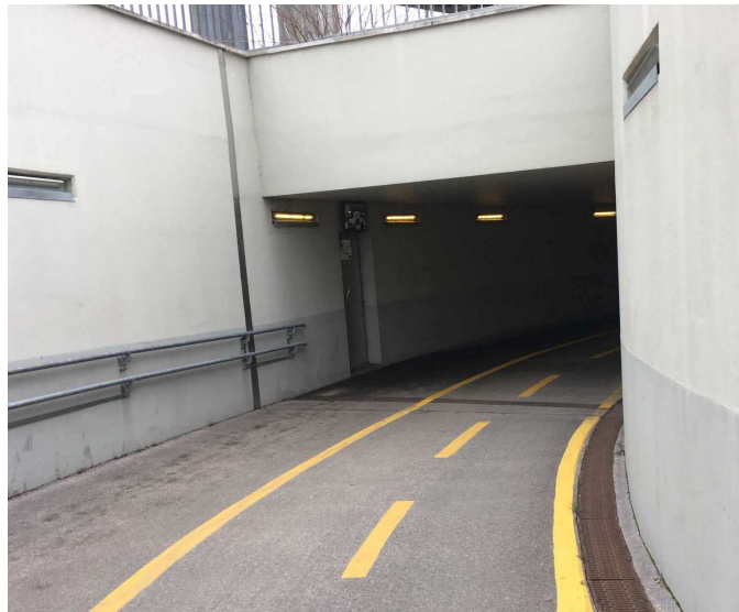
140. ábra: Csaba utca, vasút alatti kerékpáros aluljáró
