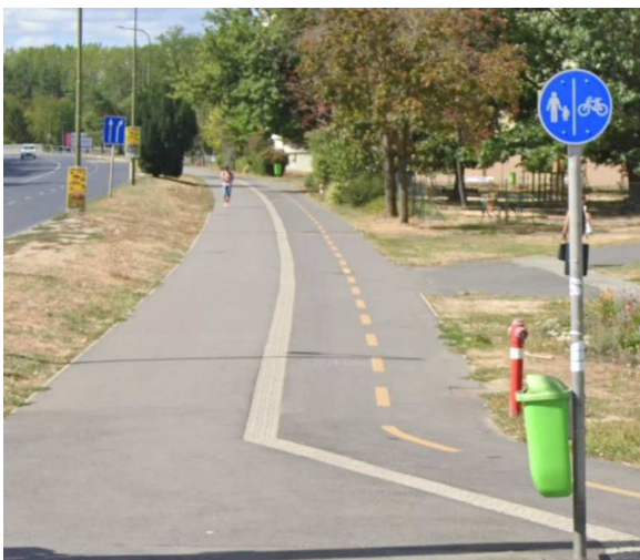
89. ábra: Egyoldali, kétirányú gyalog- és kp.út szakasz
