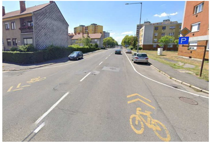
57. ábra: Szent Gellért utca, a parkolás leválasztása felfestéssel
