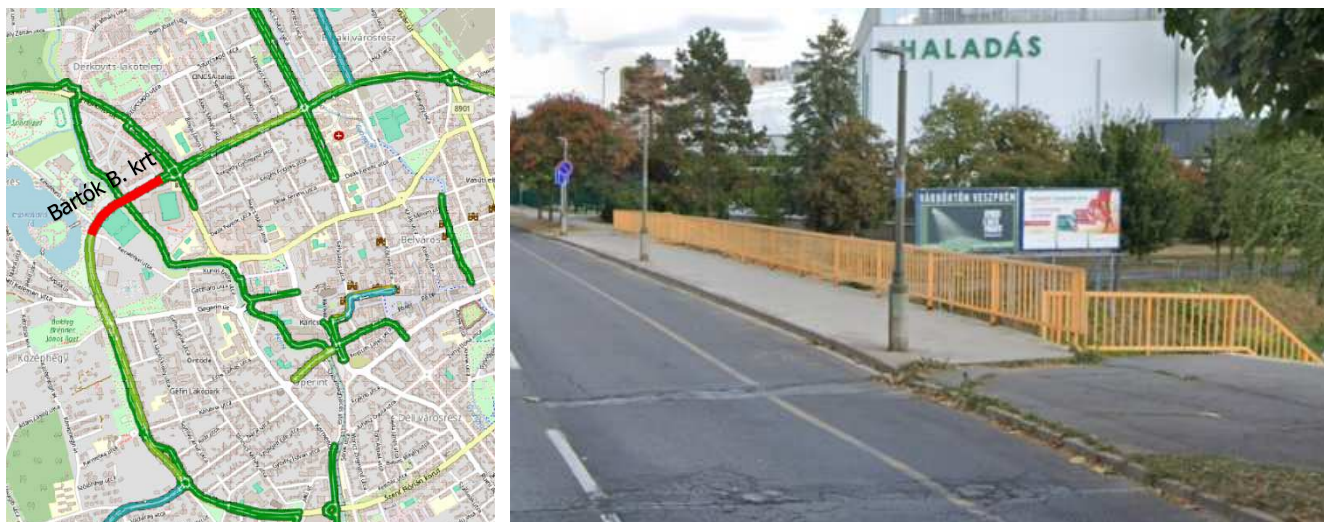
186. ábra: Bartók Béla krt., és a Perint-patak fölötti híd felújítása, kerékpársávokkal
