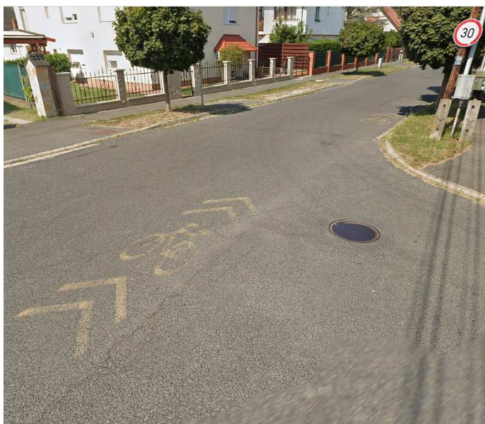
87. ábra: Megkopott útburkolati jelek a Maros utcában
