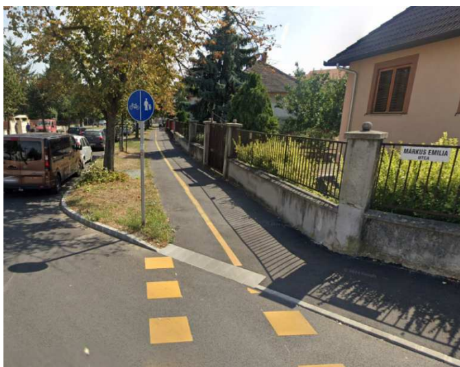
99. ábra: Északi körútrész kerékpáros létesítményei: egyirányú gyalog- és kerékpárút (É-i oldal), egyoldali kerékpársáv (D-i oldal)
