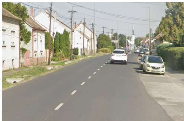
200. ábra: Rumi útnak a 86. sz. főúttól északra eső szakasza
